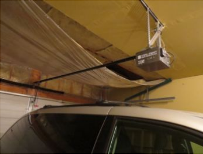
Repair vapour barrier.
